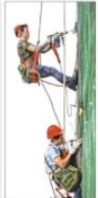
一名工作人员正在对某项工程进行施工。
